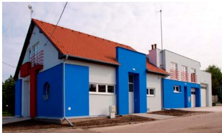
Hasičská zbrojnica v Gbeloch bola rekonštruovaná v roku 2010
