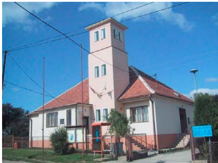
a dnes, s vežou na sušenie požiarnych hadíc
