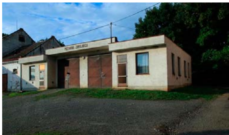
Súčasná požiarna zbrojnica
